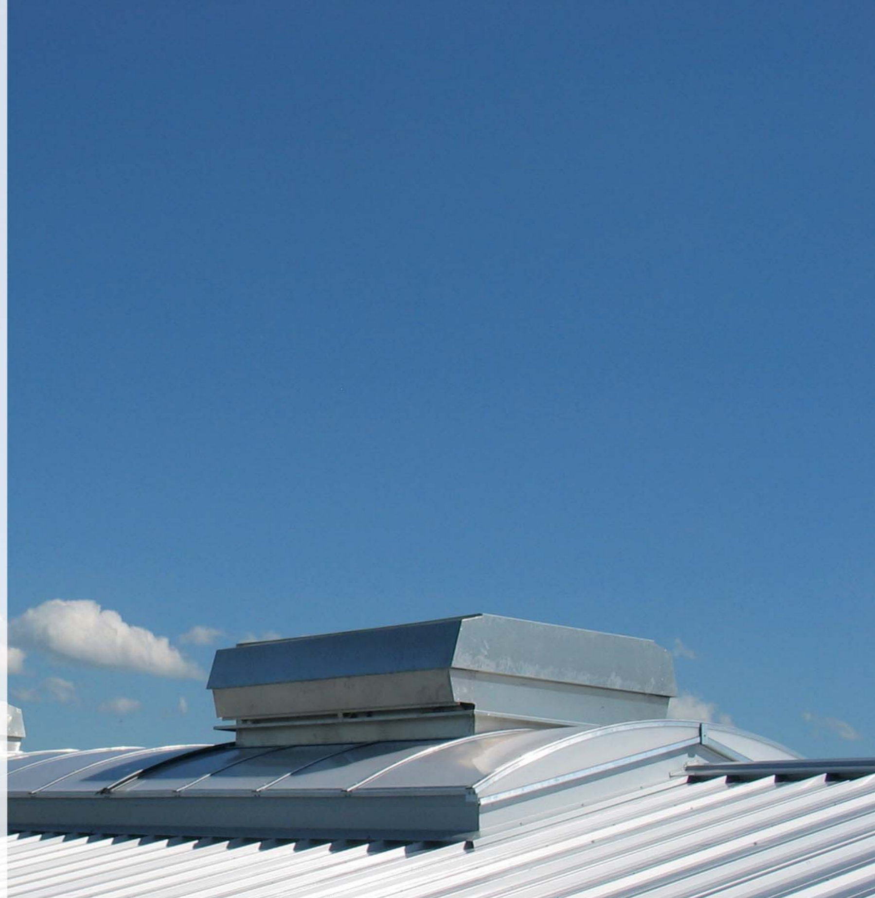
Die RWA- und Lüftungsgeräte können auch in ein Lichtband integriert werden, das Tageslicht ins Gebäude lässt und somit Betriebskosten senkt
