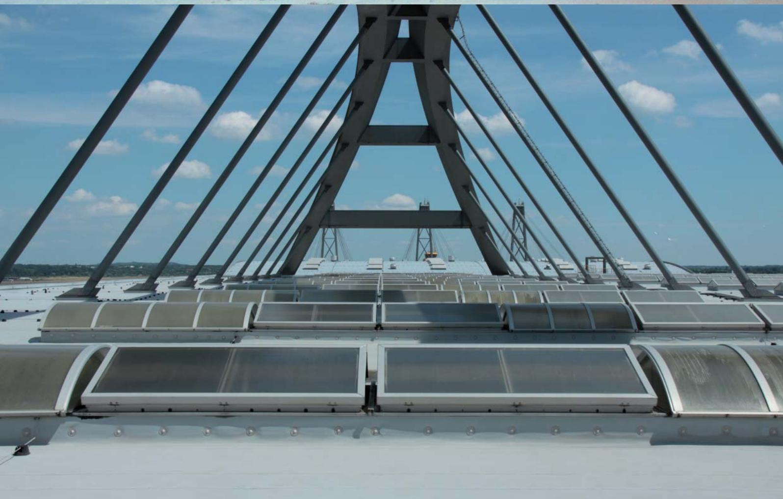
Nach 25 Jahren sind die PC-Mehrstegeplatten vergilbt und lassen deutlich weniger Sonnenlicht ins Gebäude
