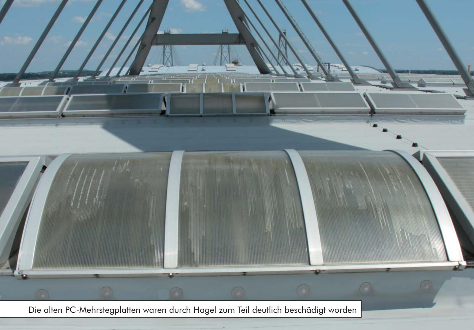
Die alten PC-Mehrsteckplatten waren durch Hagel zum Teil deutlich beschädigt worden
