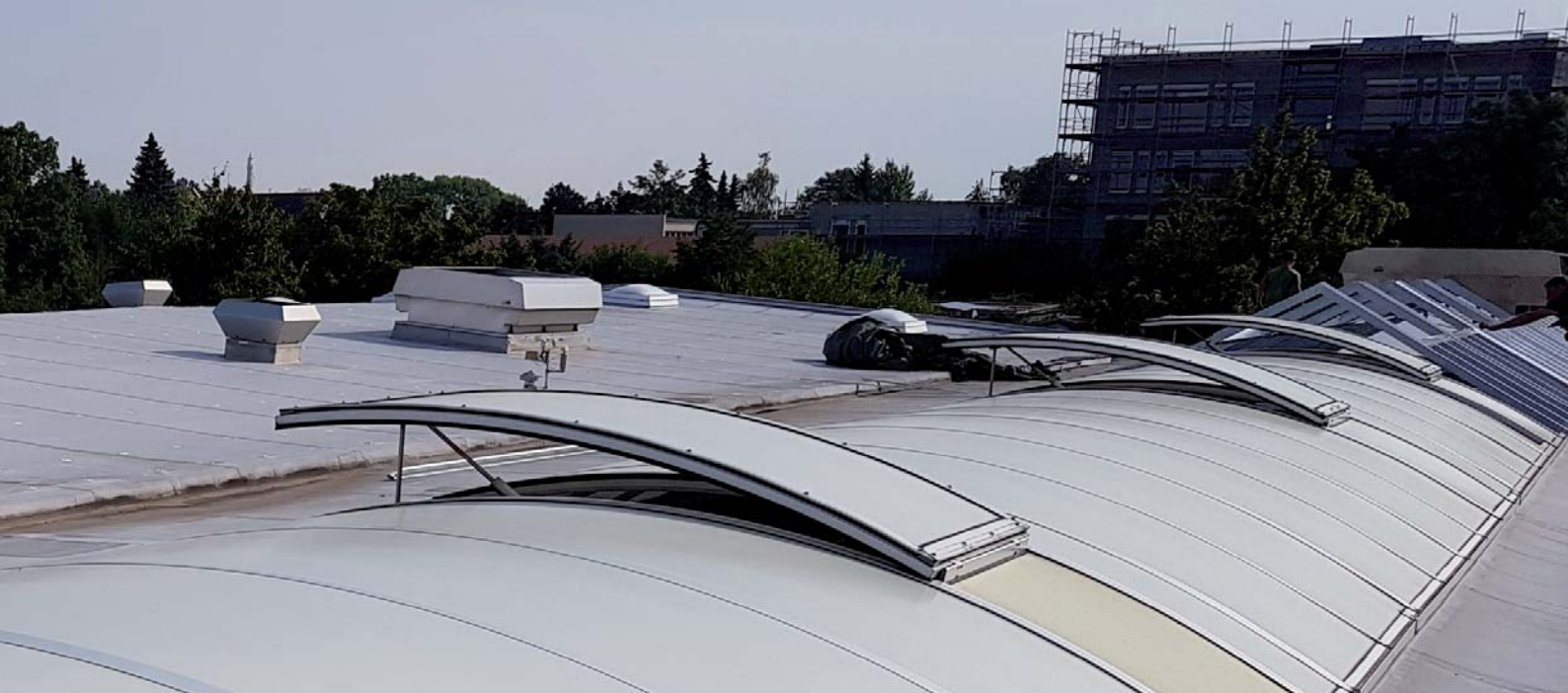
Die alten Einzelklappen ließen mit einem Hub von 300 mm nur wenig Abluft aus dem Gebäude.
