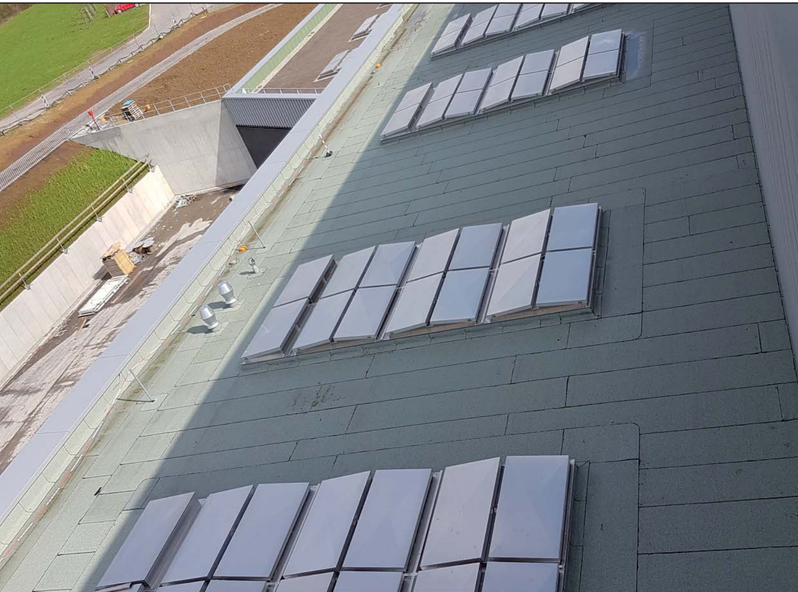
Großes Bild: Druckentlastungsklappen Typ SafetyHatch mit Aluminium-Hauben
