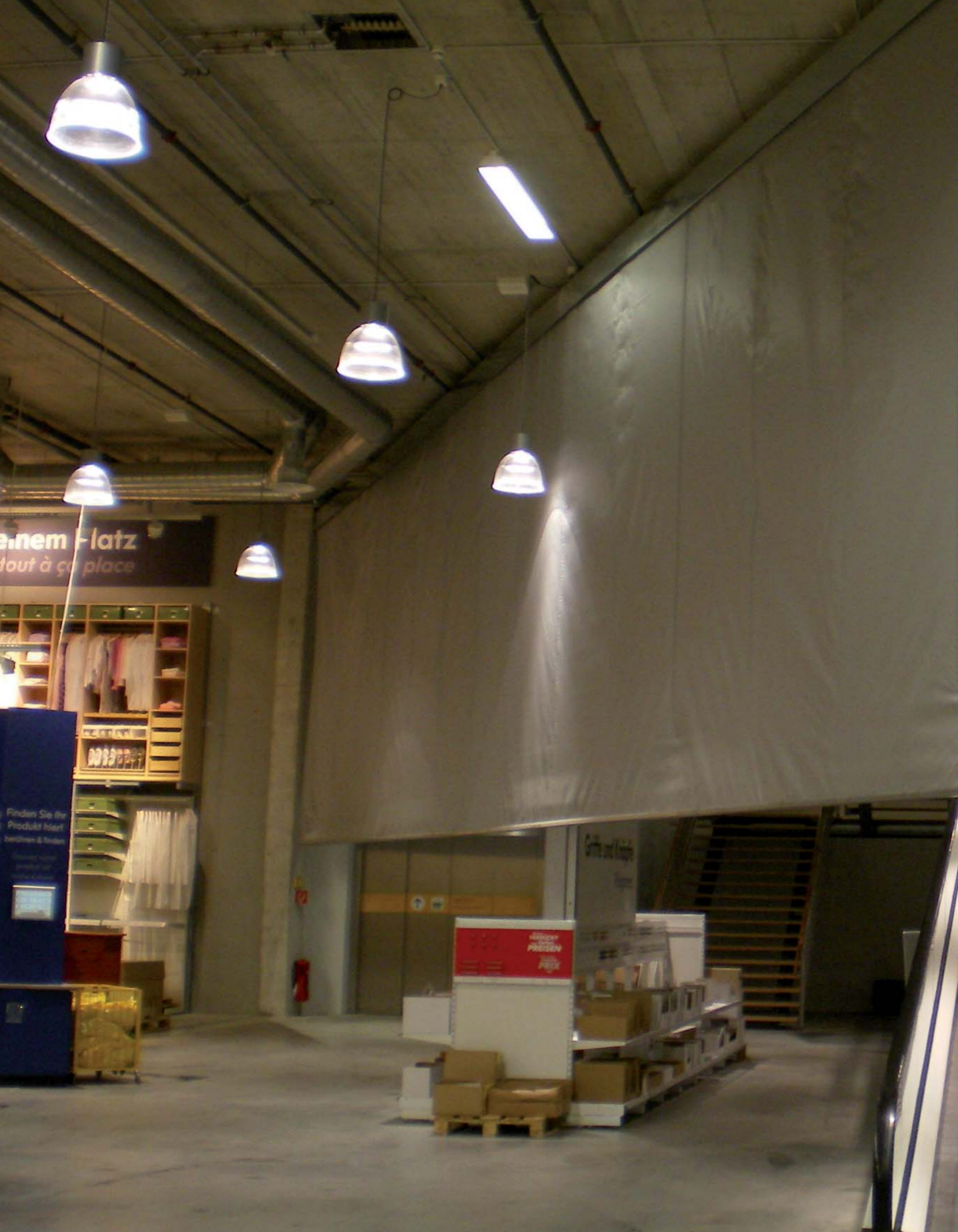
Bild: Die Rollrauchschürze fährt im Brandfall herunter, um den Treppenaufgang rauchfrei zu halten
