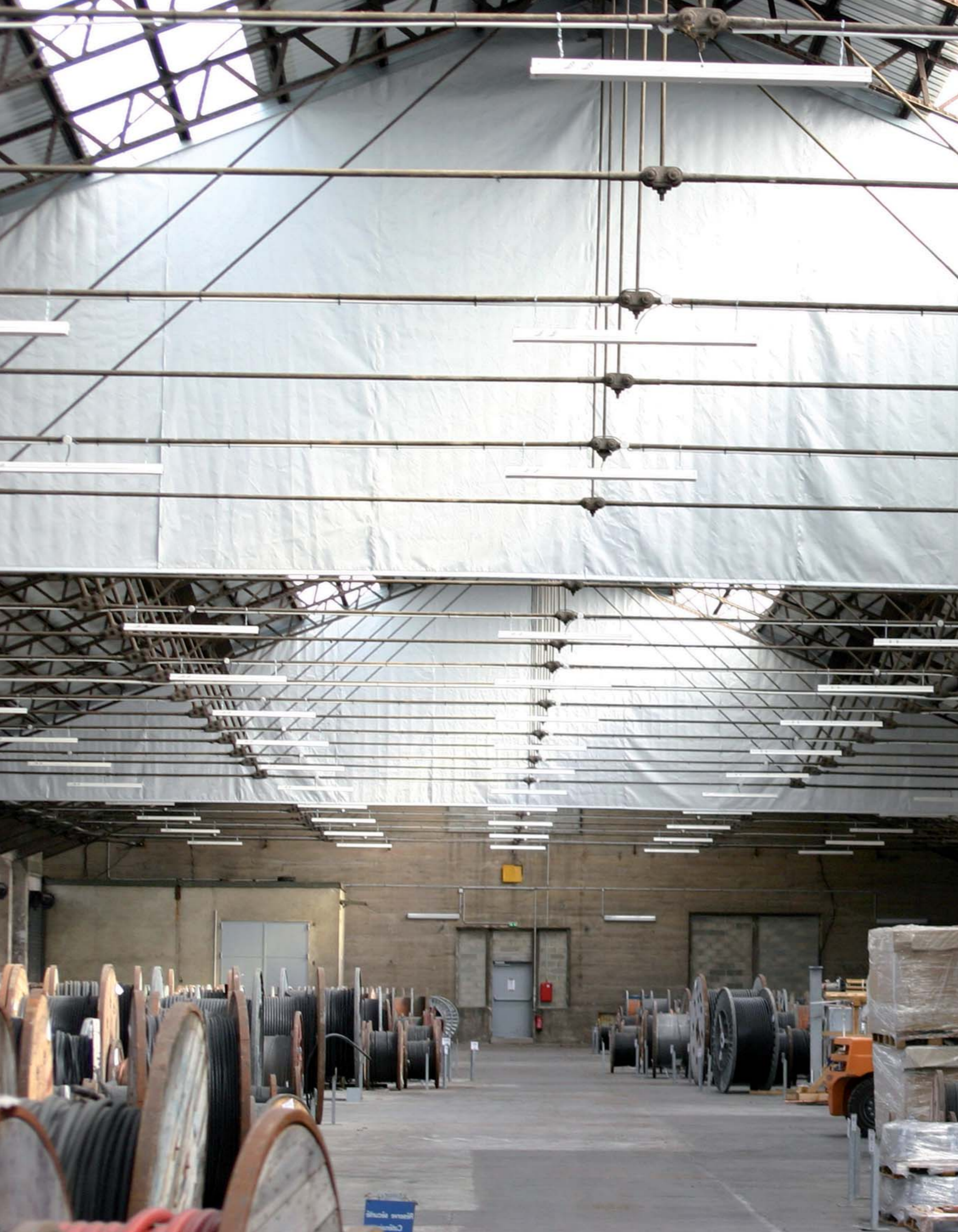
Bild: Starre Rauchschürze SmokeTex, die der Dachneigung angepasst wurde
