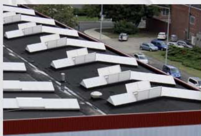
DELTALIGHT auf einer Montagehalle ...
